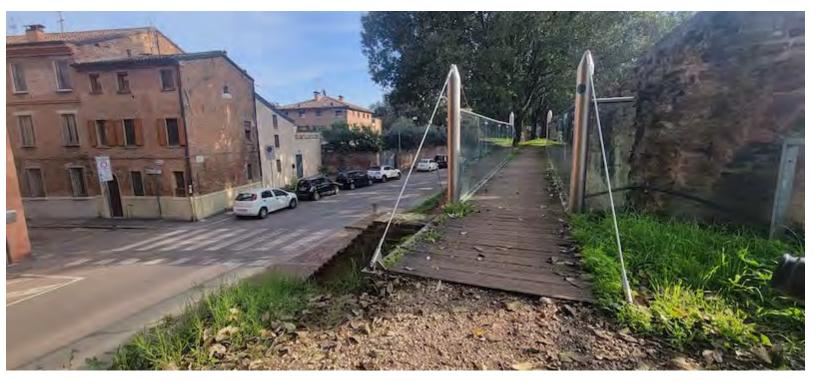
Divaricare maggiormente i tiranti che in questo momento sono una fonte di inciampo pericolosa. Nella posizione di ancoraggio a terra dei tiranti, fissare in profondità un palo verticale per lato, opportunamente verniciato o anodizzato per facilitare il riconoscimento del passaggio pedonale sospeso.
